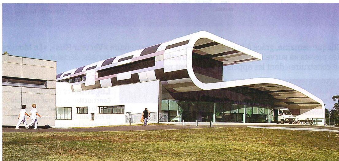
La restructuration du plateau technique de gynécologie-obstétrique du CHU d'Angers a été saluée par le prix Architecture.
